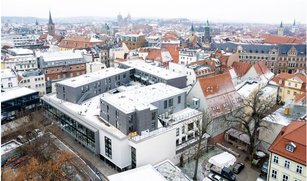
Abbildung 1: Luftansicht vom hinteren Bereich des Quartiers mit den 52 betreuten Wohneinheiten der Caritas
